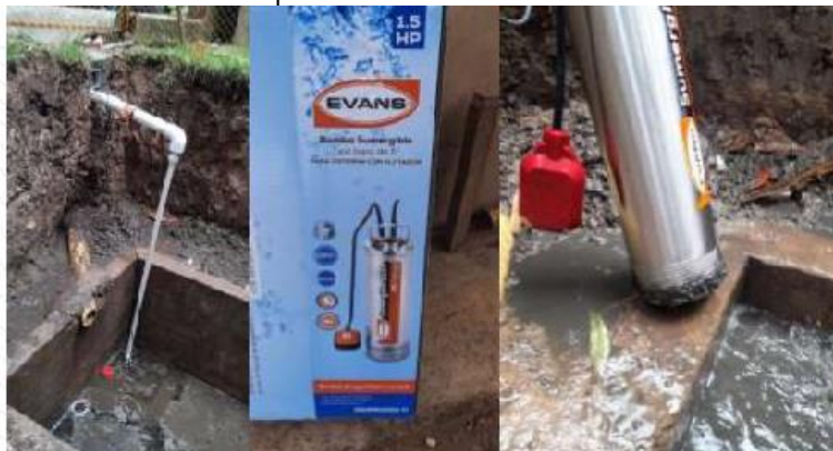
Ilustración 9. Limpieza de lixiviados CPAMSEB COMBITA.
