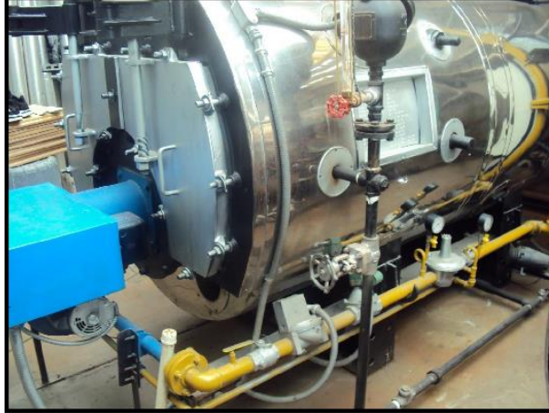
Ilustración 16. Mantenimiento de calderas COJAM JAMUNDI.
