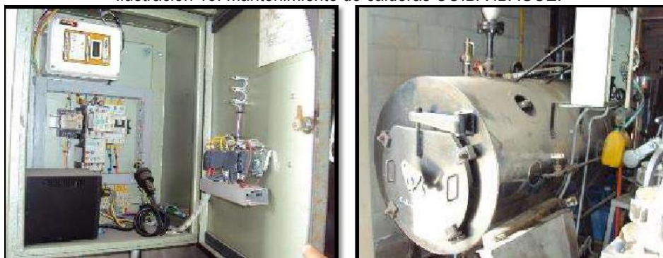
Ilustración 15. Mantenimiento de calderas COIBA IBAGUE.
