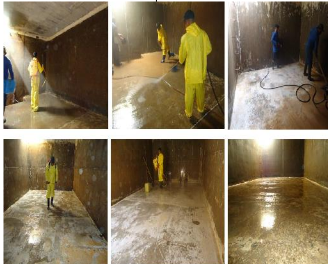
Ilustración 7. Lavado de tanques EPMSC PUERTO TRIUNFO
