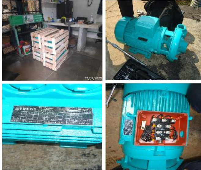
Ilustración 6. Mantenimiento electrobombas EPMSC PUERTO TRIUNFO
