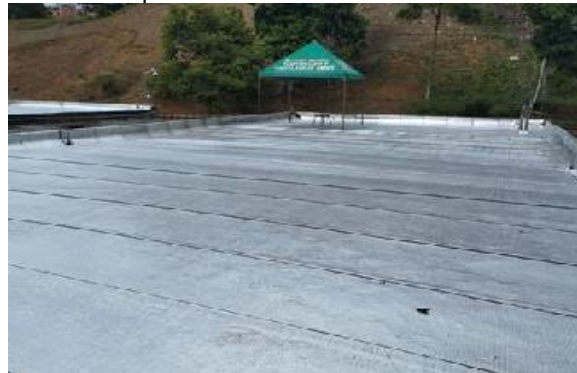
Ilustración 14. Impermeabilización de cubierta EPMSC ANDES.
