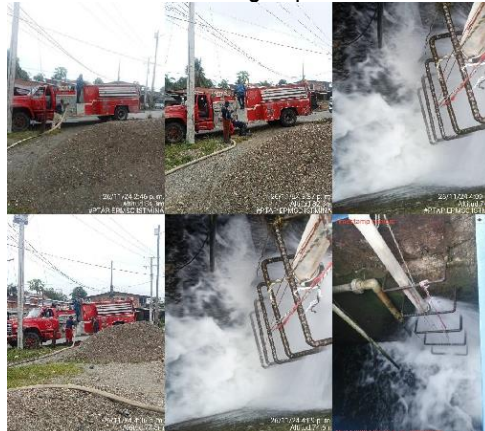
Ilustración 12. Suministro de agua potable EPMSC ISTMINA.
